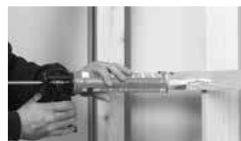
Lijmen met een krachtige elastische lijmkit
