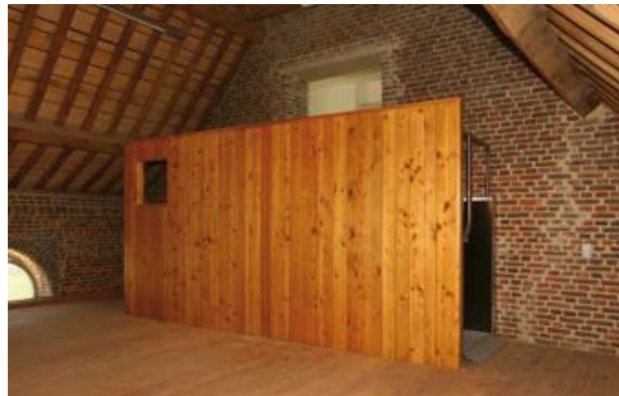
FIG. 8 Abdij Herkenrode De zolders van het hoevecomplex van de abdij zijn door middel van kooiliften ontsloten en toegankelijk gemaakt. Om de vloerniveaus van de zolders via het hoger vloerniveau van de centraalbouw met elkaar te verbinden moesten bijkomende trappen voorzien worden. Om de zolders ook voor rolstoelgebruikers met elkaar te verbinden, heeft de restauratie-architect platformliften voorzien. De platformliften en trappen zitten verscholen achter een gesloten houten wand die meteen ook dienst doet als borstwering voor het trapbordes. (© VIOE, foto Kris Vandevorst)
